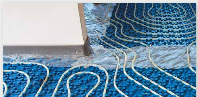
Anschluss an Fußbodenheizung: unsichtbare Installation; Komfort und gleichmäßige, optimale Temperatur.
